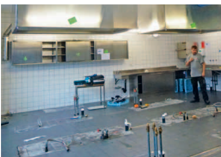
Die Schulküche wurde total demontiert ...
