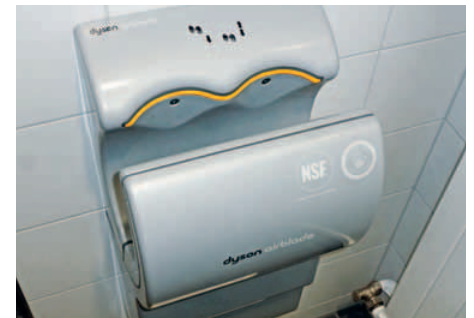
Erneuerung der sanitären Anlagen
